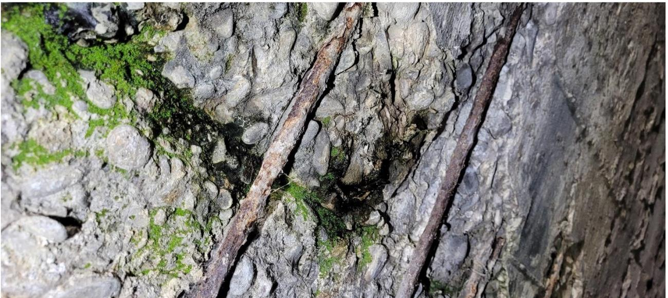
*Figura 13 Campata centrale, percolazione acqua*
