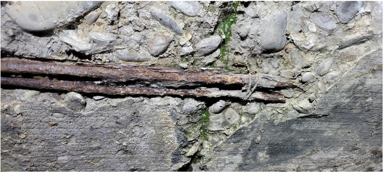
*Figura 12 Campata centrale, nuova fessura*
