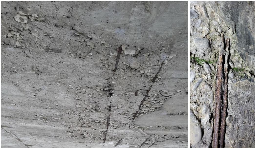
*Figura 9 Espulsione del copriferro e successiva corrosione barre di armatura*
