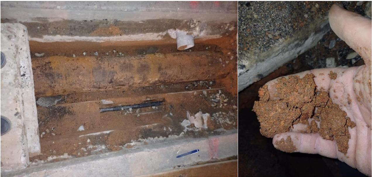
*Figura 14 Cordolo condotta marciapiede, presenza umidità nell'intorno della tubazione*
