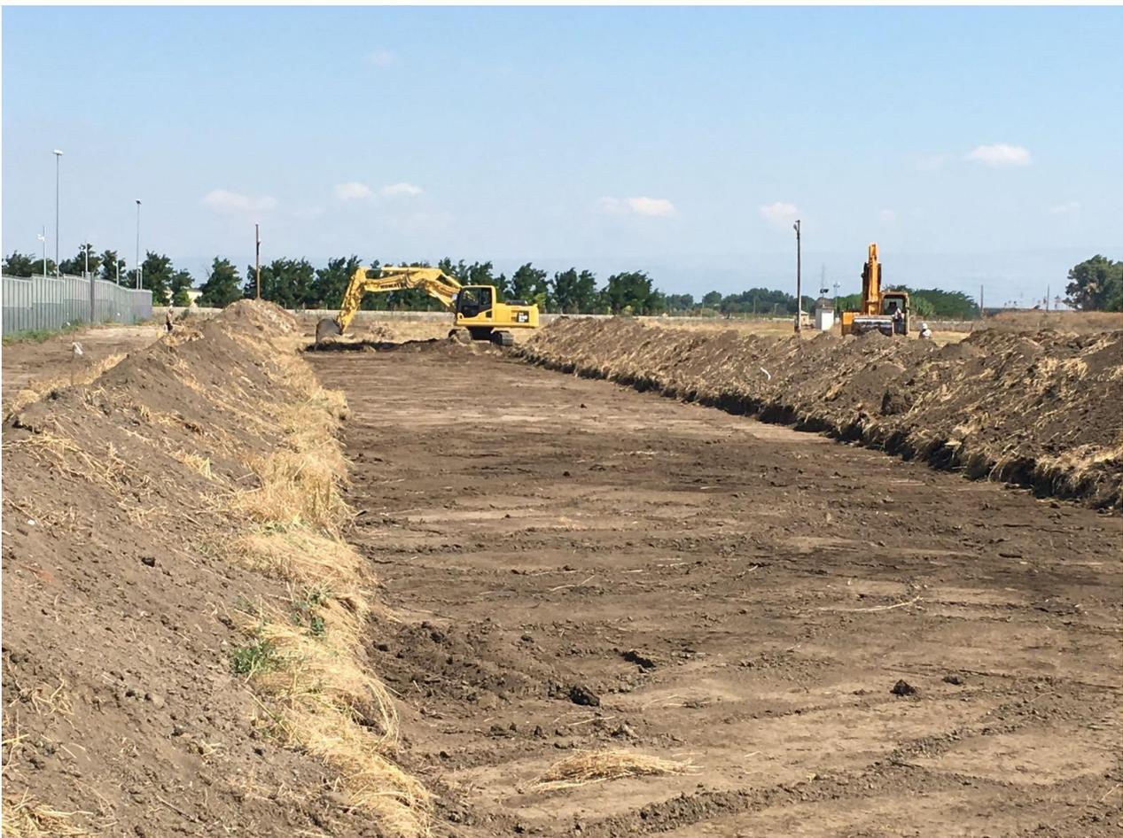
*Immagine 1 - Rimozione del primo strato di terreno con ausilio di mezzo meccanico munito di benna liscia e operaio a terra per vaglio di terreno escavato con ausilio di magnetometro*
