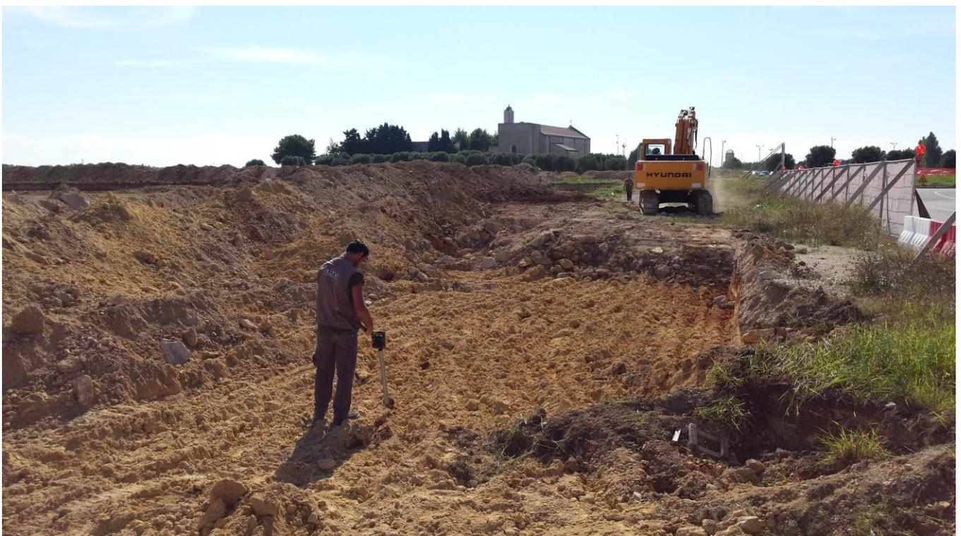
*Immagine 3 – Esecuzione ispezione strumentale nelle varie fasi di scavo con ausilio di magnetometro*
