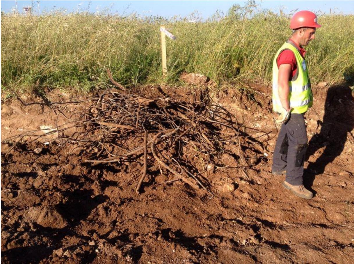
Immagine 2 – Cernita del materiale escavato con raccolta ed accantonamento delle masse ferrose rinvenute
