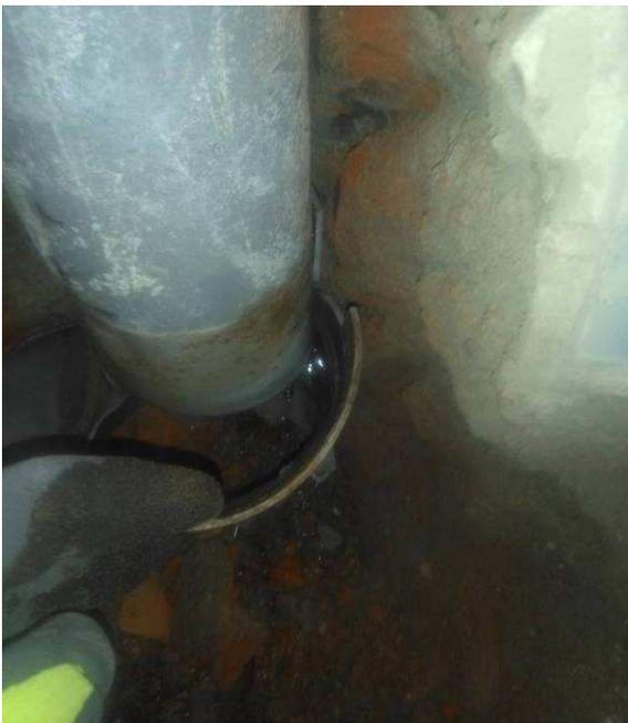
*dettaglio pluviale esistente danneggiato*
