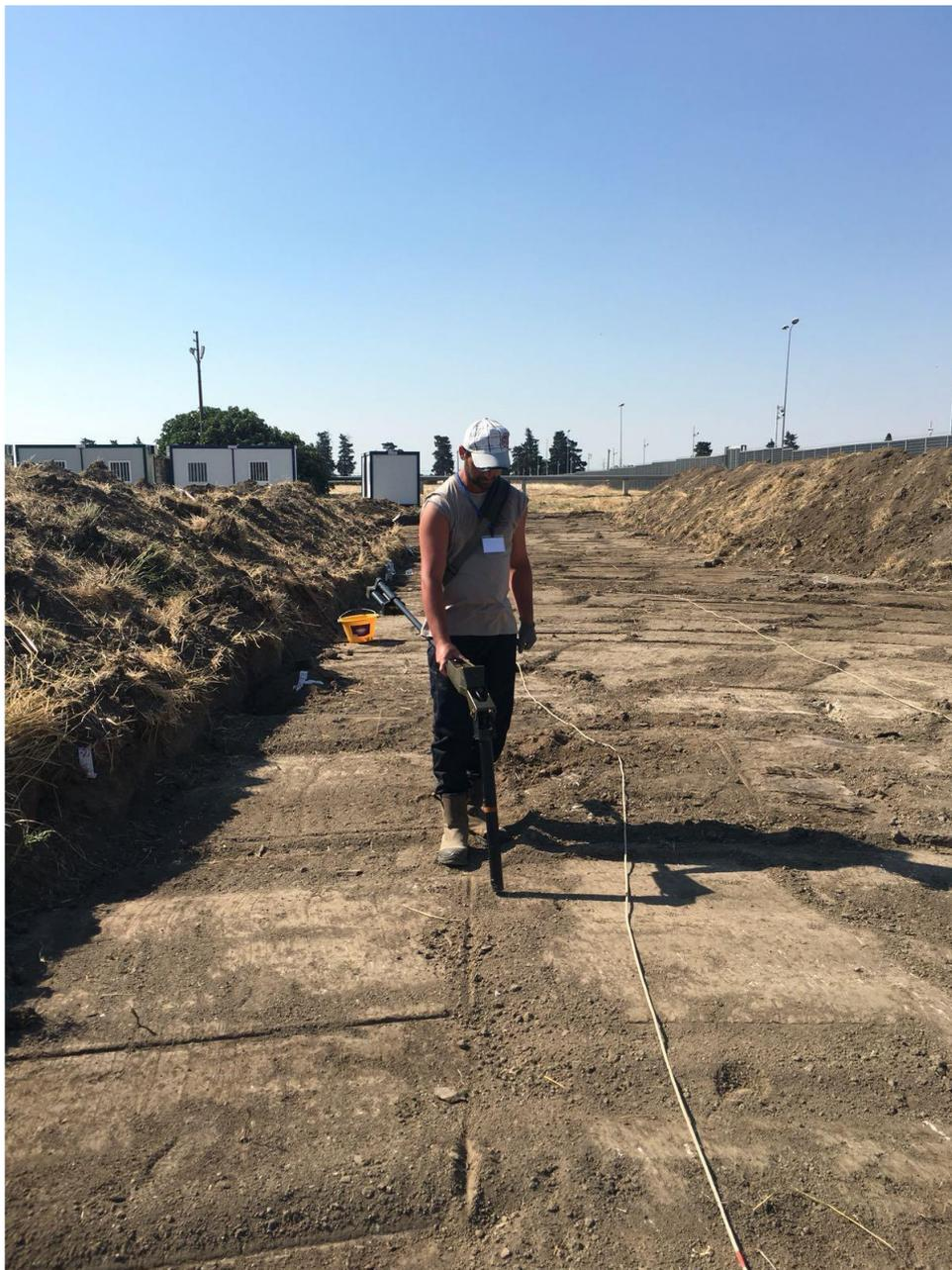
*Immagine 12 - Verifica del fondo scavo mediante bonifica superficiale con suddivisione della fascia in strisce da 0,80 mt. x 0,80 mt. ed ausilio di magnetometro*
