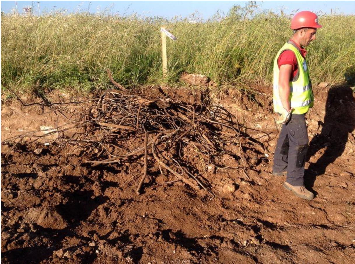
Immagine 8 – Cernita del materiale escavato con raccolta ed accantonamento delle masse ferrose rinvenute
