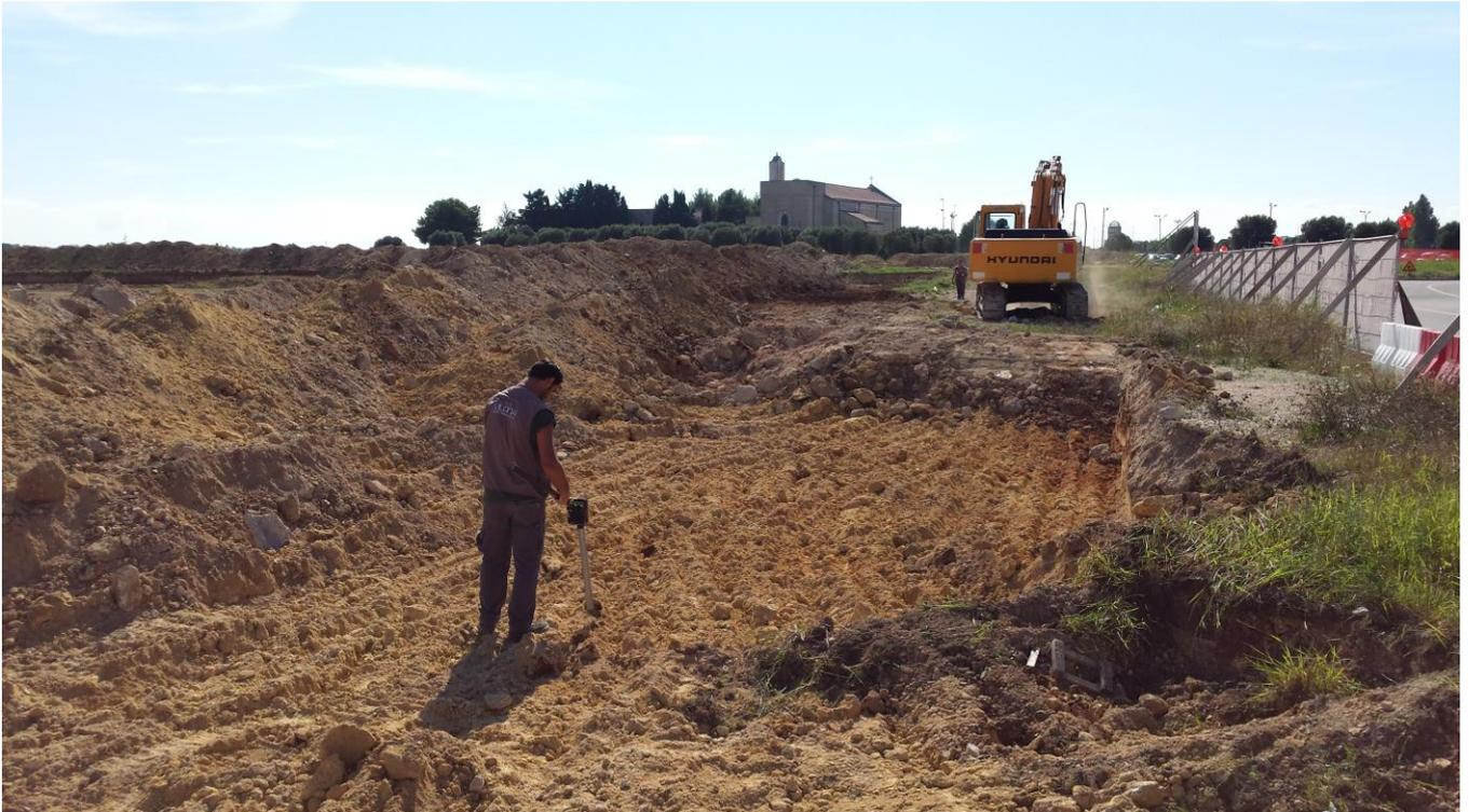
Immagine 10 – Esecuzione ispezione strumentale nelle varie fasi di scavo con ausilio di magnetometro
