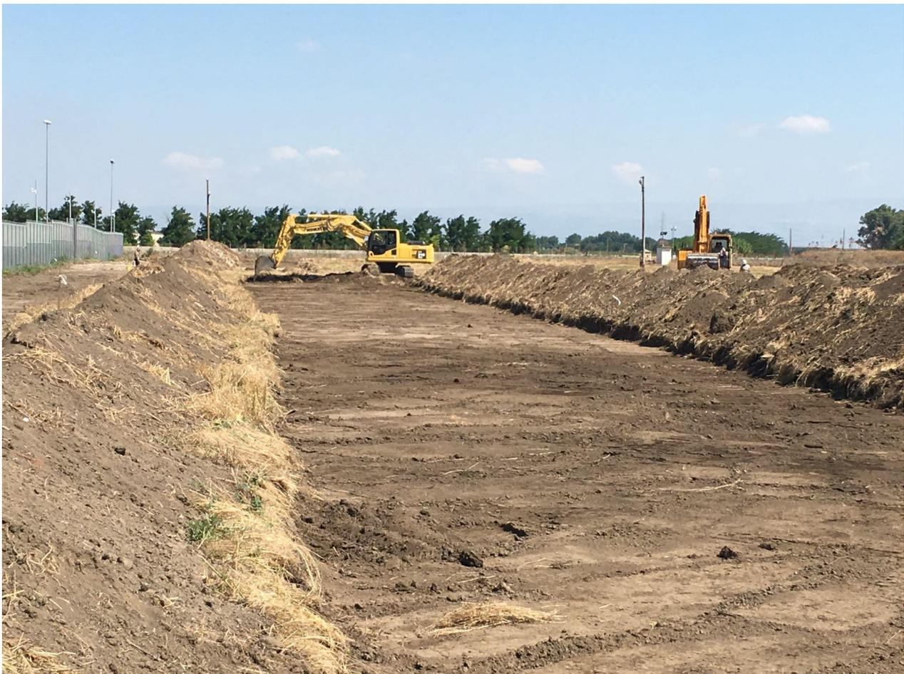
Immagine 6 - Rimozione del primo strato di terreno con ausilio di mezzo meccanico munito di benna liscia e operaio a terra per vaglio di terreno escavato con ausilio di magnetometro
