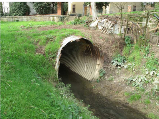
⑥ P1 - TUBO FINSIDER ( VIA DELLA NAVE )
