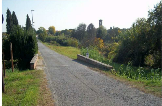
⑦ P2 ( VIA DELLA NAVE )
