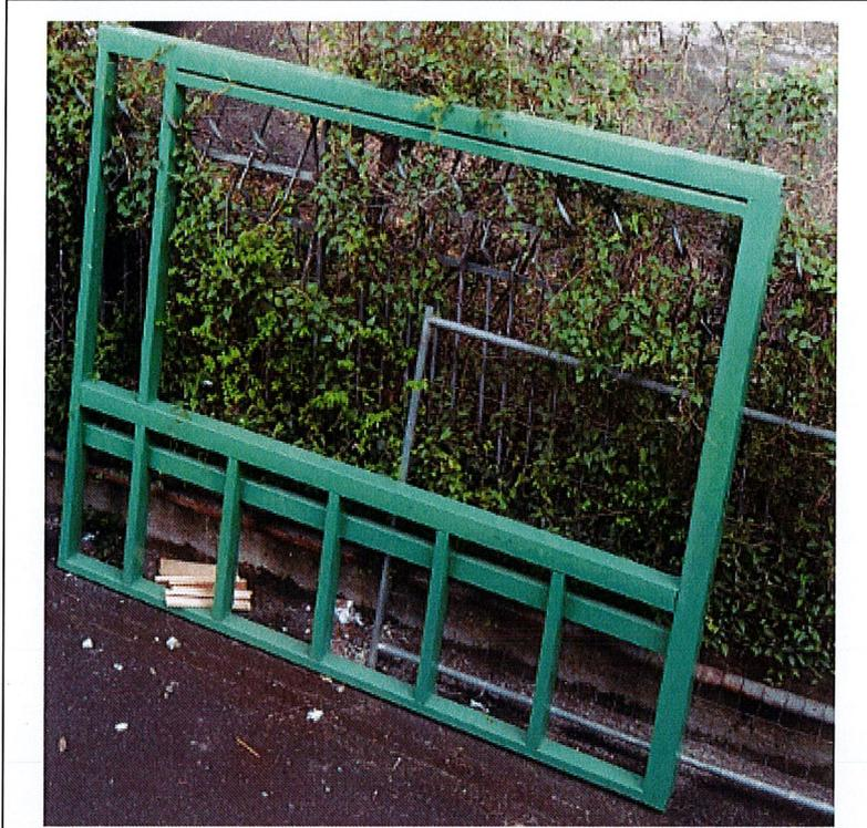
Fig. 4.: Struttura di supporto costituito da telaio in carpenteria metallica
